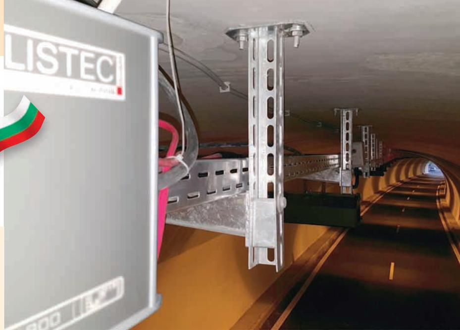
▲ Die neue A3 in Bulgarien: Die LIST-Sensorkabel lokalisieren punktgenau Gefahren im Tunnel.
