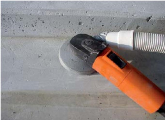
Abb. 1: Untergrundvorbereitung Schleifen
