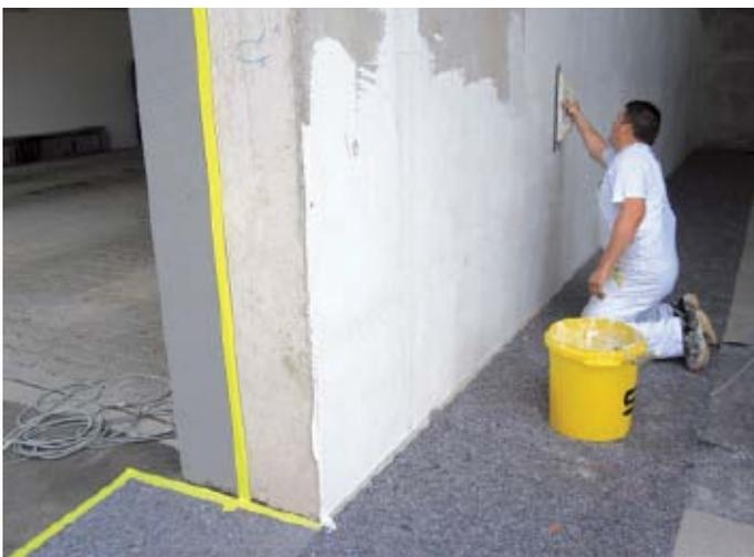
Abb. 2: Schließen der Löcher und Lunken mit Egalisierspachtelung
