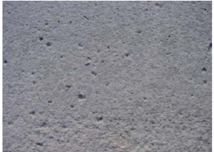
Abb. 3: Löcher und Lunken in vorbereiteter Betonoberfläche
